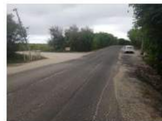
PR 4+900, ouvrage hydraulique et intersection
