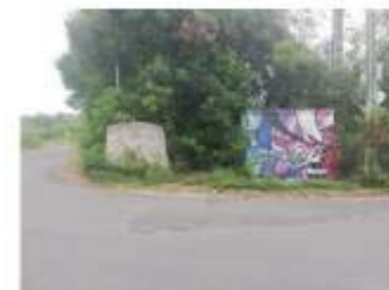
Outillage et poste électrique à l'intérieur du village
