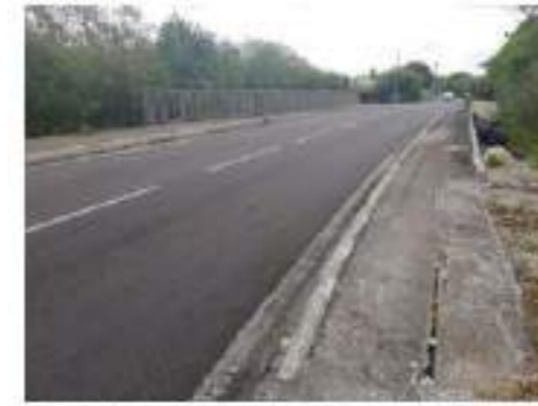
Port sur la ravine Kahouanna, vue en direction de la Pointe-des-Châteaux
