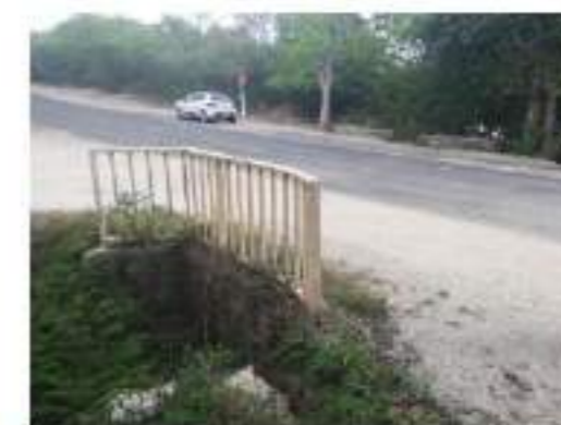
PR 4+900, ouvrage hydraulique
