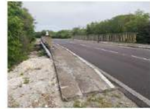
Port sur la ravine Kahouanna, vue en direction de Saint-François
